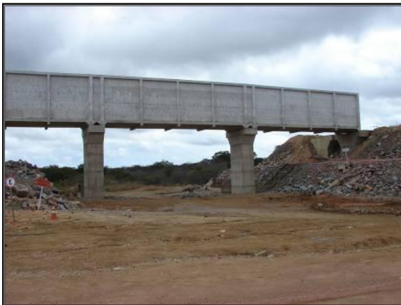
Foto 23.1. Aquedutos Lote 1 Trecho I.
